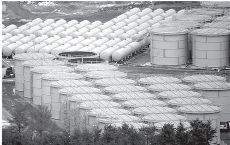
染水を溜めるためのプールが7基作られたが、汚染水が漏洩して役にたたなかった。地上のタンクに貯蔵するのにも、限界がある。
