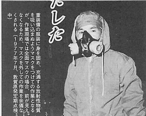
重装備の服装に身を固め、充滿する放射性物質を吸い込まぬようマスクをつけての作業となるが、作業現場では全面マスクの場合、前が見えなくなるため、マスクを外しての作業を余儀なくされる（1977年7月、敦賀原発定期点検中）
