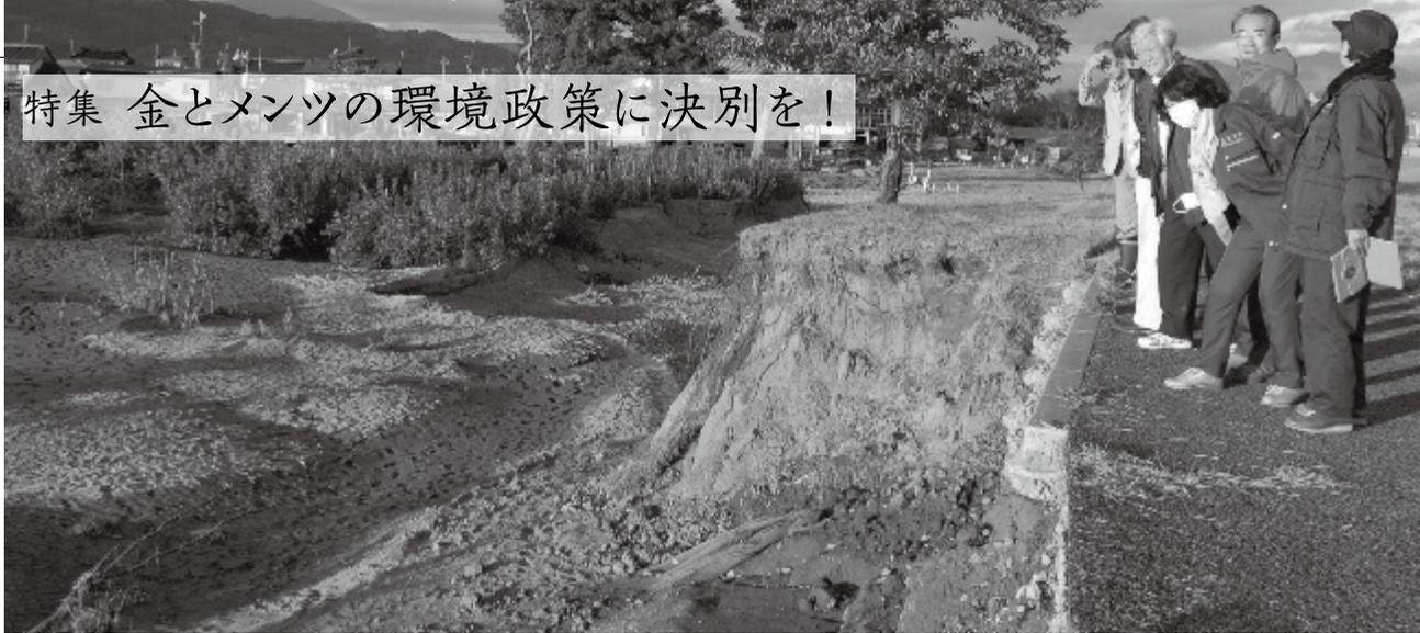
家屋を濁流が飲み込んだ決壊地点（新潟・長野県境から千曲川58km地点）での決壊幅は70mだが、間際の堤防も決壊寸前まで破壊され、堤防天板のアスファルトで持ちこたえていた。（2019年11月11日、筆者撮影）
